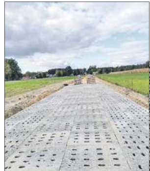
Realizowana jest budowa dwóch dróg w Nowosiólkach, w tym drogi przejętej od powiatu przez gminę na długości 3,7 km
