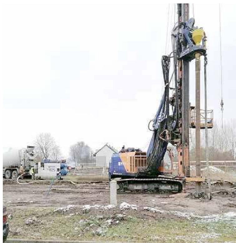
Na placu budowy osiedla przy Kolejowej pracuje palownica
