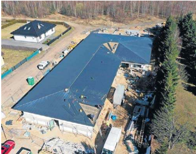
Bryła budynku już została wybudowana i zadaszona
