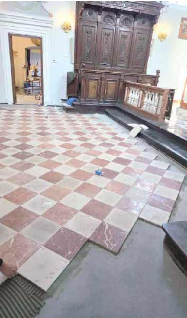
W kościele Trójcy Świętej w Radzynie Podlaskim trwają intensywne prace remontowe. Rozpoczęto właśnie układanie marmurowych płytek na posadzce, co całkowicie odmienia wnętrze świątyni. Zgodnie z zapowiedziami, wierni będą mogli powrócić do kościoła już w najbliższych tygodniach, kiedy prace dobiegną końca.
