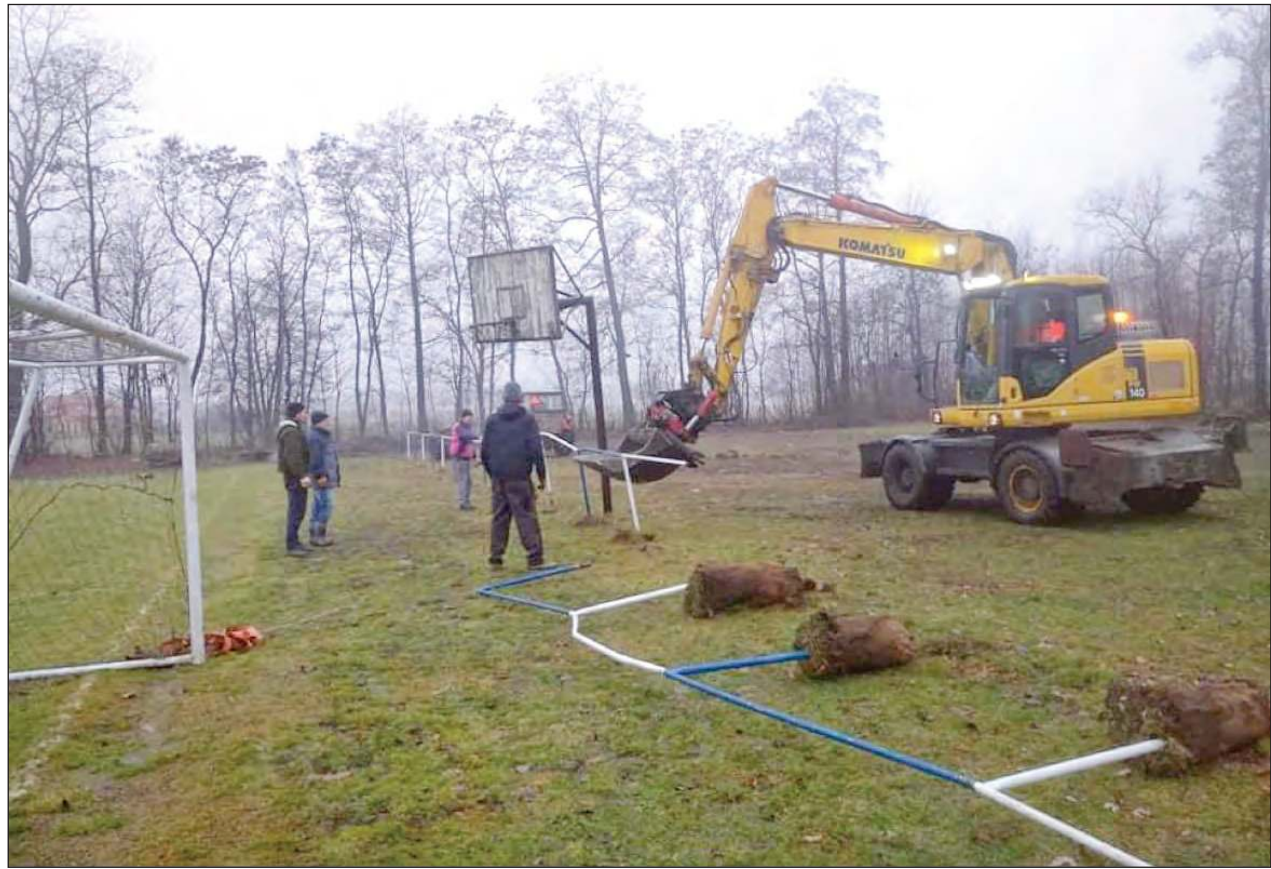
Na początku grudnia rozpoczęto prace. Udało się wyciąć drzewa, które przeszkadzały w przedsięwzięciu i wyrównać teren (fot. KS Amator)
