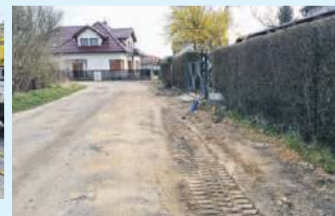
Trwają prace budowlane na części ulicy Okólnej
