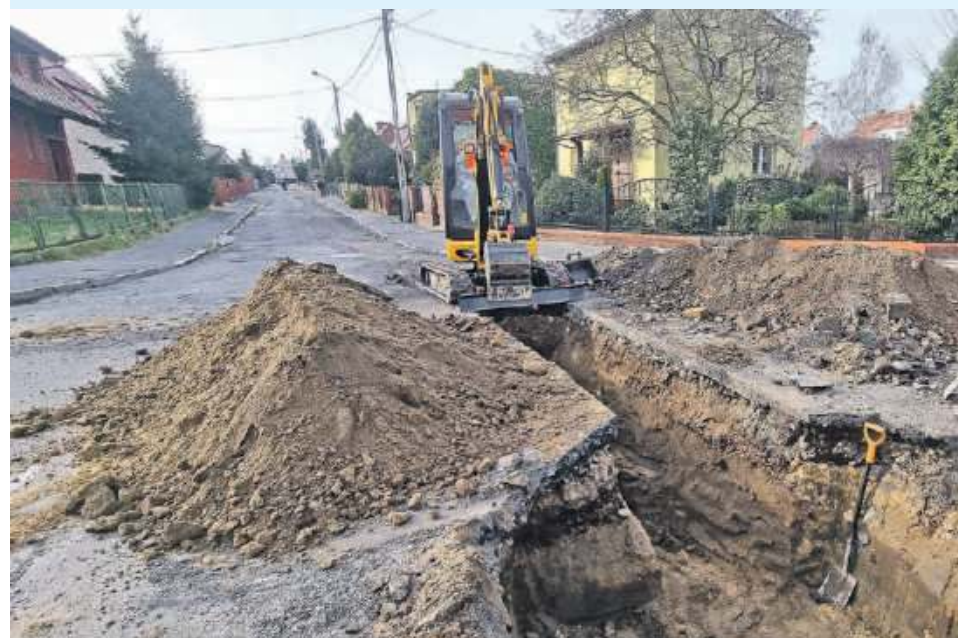
Rozpoczął się remont kolejnej drogi miejskiej - ul. Dąbrowskiego
