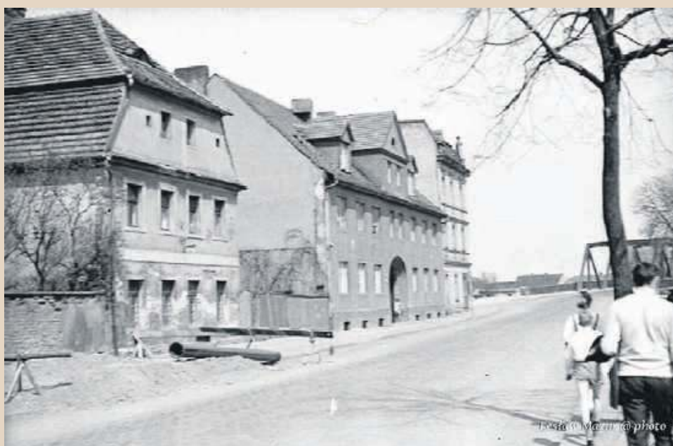
Ulica Bolesława Chrobrego w 1968 roku - drugi budynek od Odry miał dużą bramę wjazdową (dziś jest zamurowana) - tu mieszkała kuzynka pani Reni Tkaczyk, która zapamiętała, że na podwórku stało bardzo dużo nowych furgonów do przewożenia chleba. Z tego wynika, że tu mógł być magazyn gotowych furgonów
