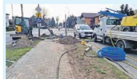
Trwa modernizacja ul. Zacisznej. Inwestycja realizowana przez Starostwo Powiatowe oraz Urząd Miejski w Olawie
