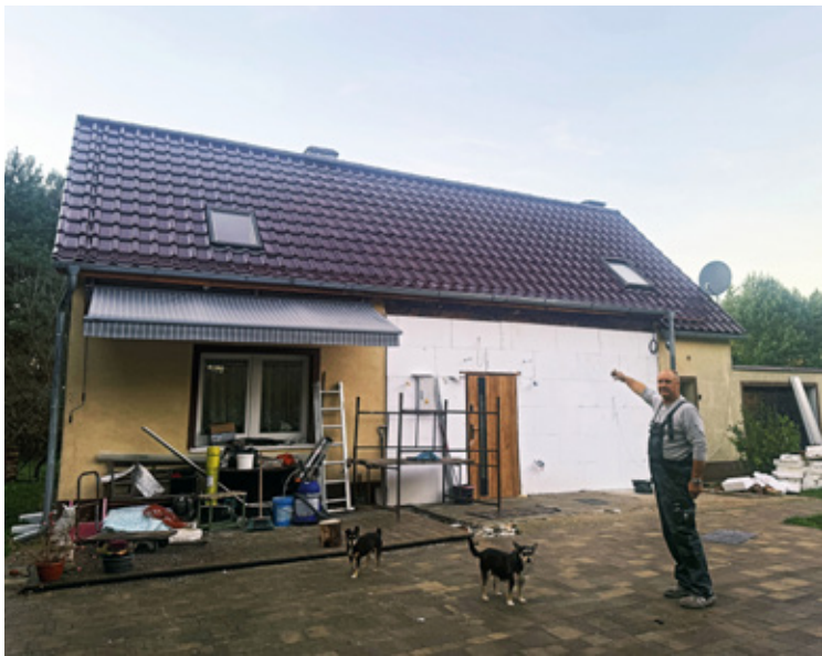
Tak jest... Pan Olszewski remontuje dom po wyburzeniu ganku.
