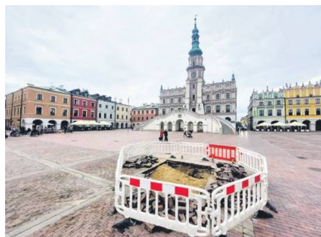
W tym miejscu woda najprawdopodobniej wypłukała piasek, dlatego doszło do obniżenia gruntu. Fot. Konrad Sinica
