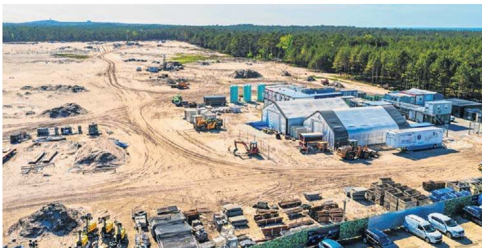
Prace przygotowawcze w miejscu budowy pierwszej elektrowni jądrowej
