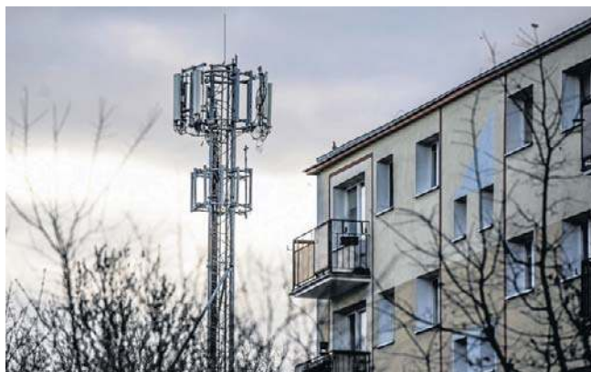
Mieszkańcy chcą wsparcia ws. zablokowania inwestycji
