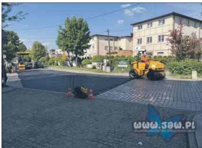
Prace na ulicy Inwalidów Wojennych
