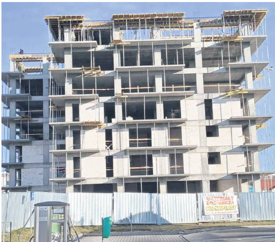
Przy ul. Kresowej Spółdzielnia Mieszkaniowa Pracowników Służby Zdrowia buduje 3 dziewięciokondygnacyjne bloki.
