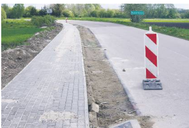
Modernizacja drogi w Kamieniu-Kolonii
