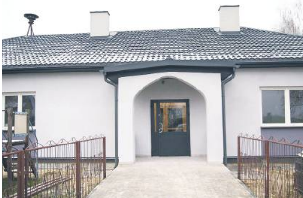
Wyremontowana świetlica w Ignatowie-Kolonii
