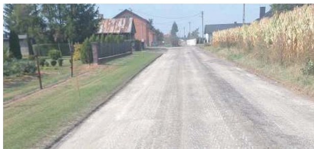
W trakcie przebudowy jest droga gminna G101527L o długości 1,75 km w Tłuszczu
