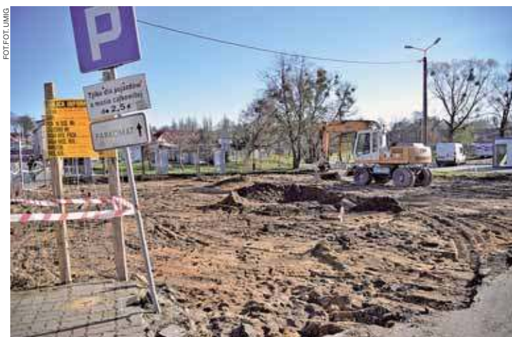
Budowa miejsc parkingowych
