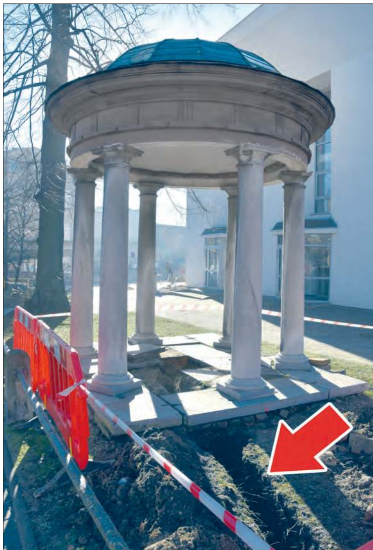
W Glorietcie zdemontowano część posadzki oraz doprowadzono rów do fundamentów
