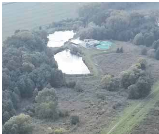
Świerkłanieccy radni zgodzili się na przystąpienie do zmiany miejscowego planu zagospodarowania przestrzennego przy oczyszczalni. Jest pomysł władz gminy, by powstała tam instalacja przetwarzania odpadów biodegradowalnych
