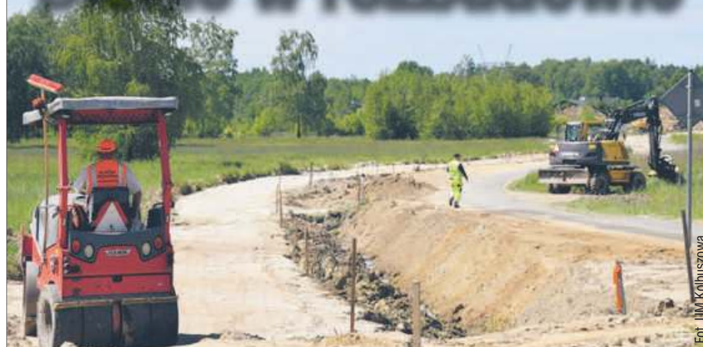
Trwają zaawansowane prace przy rozbudowie drogi gminnej ulicy Błonie w Kolbuszowej.
