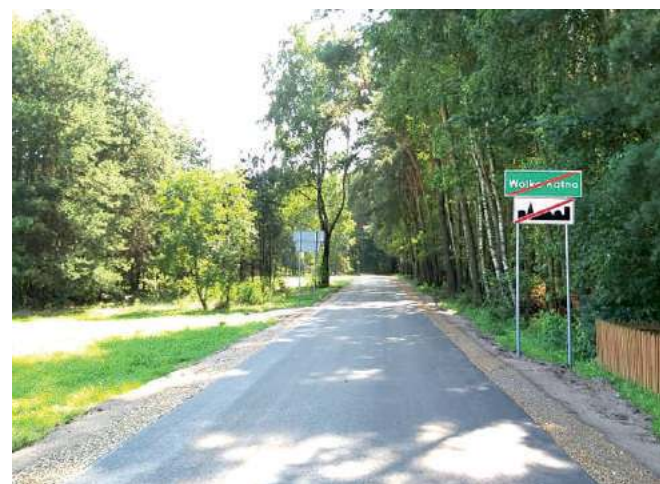
Drogowcy położyli nowy asfalt, a pobocza wzmocnili kruszywem
