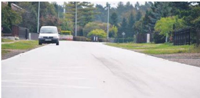
W pierwszym etapie przebudowano drogę na odcinku prawie 8 km z Łabuniek Pierwszych do Wolicy Śniatyckiej.
