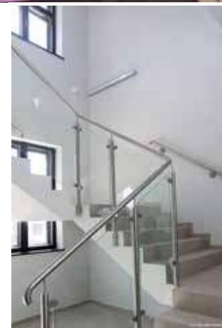
Klatka schodowa - po remoncie
