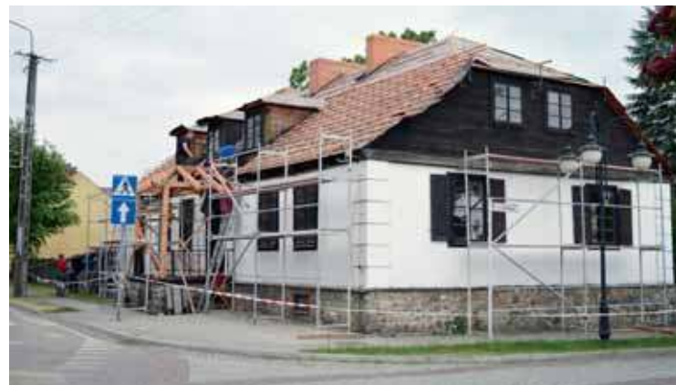
Prace przy przebudowie muzeum w Biezuńu
