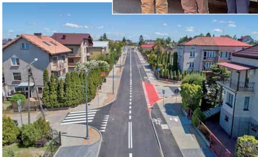
Widok zmodernizowanej ulicy Leśnej w Ciechanowie
