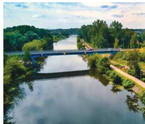
NIEPORĘT. Rozbiorą most w ciągu ul. Izabelińskiej
