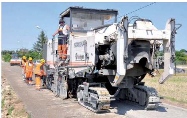
Technologia recyklingu na miejscu wykorzystywana była już w naszej gminie m.in. przy przebudowie dróg w Podzamczu, Witaniowie, Ciechankach Łęczyńskich i na odcinku ulicy Wierzbowej. Na zdjęciu - praca recyklera w Podzamczu
