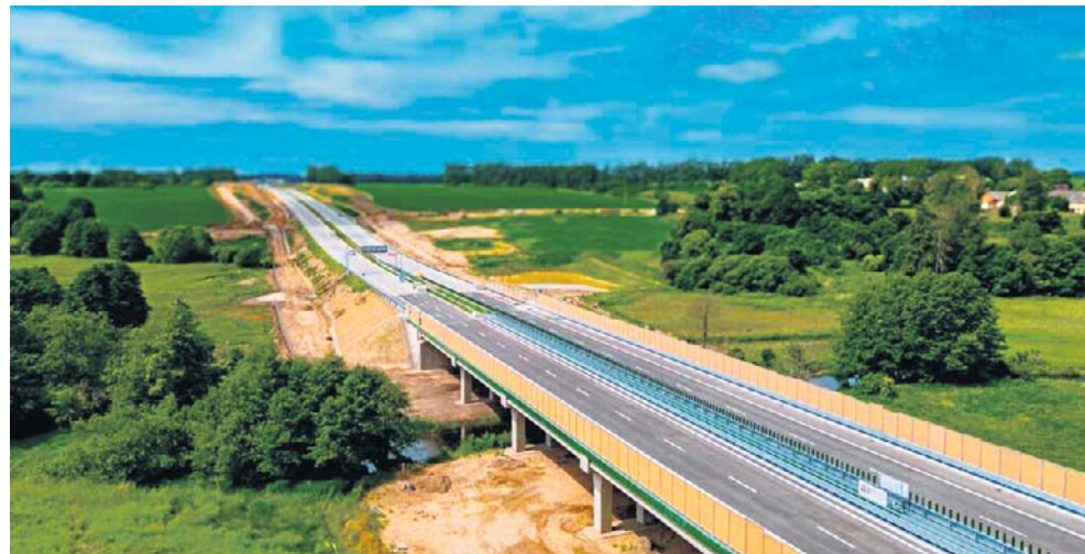
40-kilometrowy odcinek drogi S6 zostanie oddany dla kierowców już w piątek
