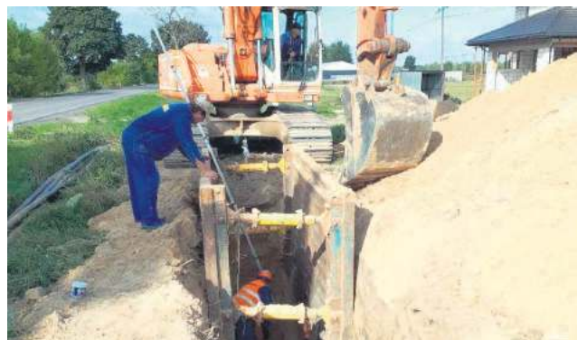
Trwa rozbudowa sieci wodociągowej i kanalizacji sanitarnej przy ul. Janowskiej we Frampolu.
