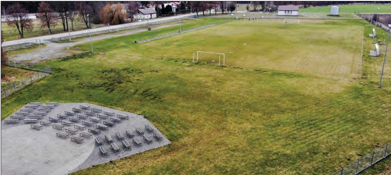
■ Sportowy obiekt w Starym Zadybiu jest znany z działalności sportowej Piekiełka Przykwa i dożynek gminnych. Dzięki zbliżającej się inwestycji, plac przejdzie metamorfozę. Pojawią się nowe budowle sprzętu oraz infrastruktura, która powinna spodobać się sportowcom i mieszkańcom (fot. UG Kłoczew)
