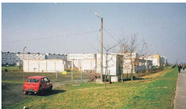
Rok 2001 - rozpoczętą budowę garaży, adaptowaną na galerię handlową, PSS „Społem” odkupiła od osoby prywatnej, ul. Iwaszkiewicza 9, z albumu PSS Społem. Tu powstanie „Jakub”
