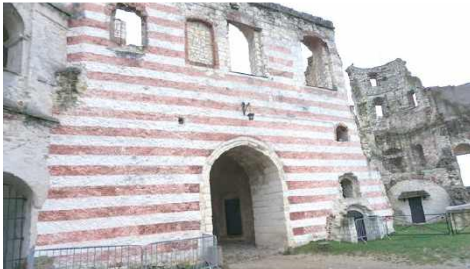
„Zabezpieczenie konserwatorskie Budynku Bramnego Zamku w Janowcu” oraz „Rewaloryzacja zabytkowej tkanki Zamku w Janowcu” za 7 mln zł będą realizowane
