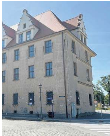
Zakończył się remont dachu.
