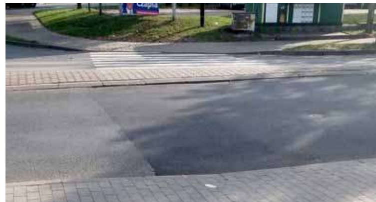
O tym przejściu informuje nas czytelniczka, pasy po jednej stronie jezdni są po drugiej niestety brak
