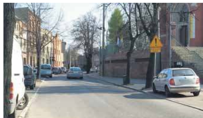
W planach jest gruntowny remont drogi oraz chodników
