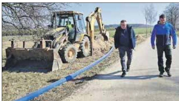
Trwają prace w zakresie przebudowy odcinka sieci wodociągowej w Łuniewie
