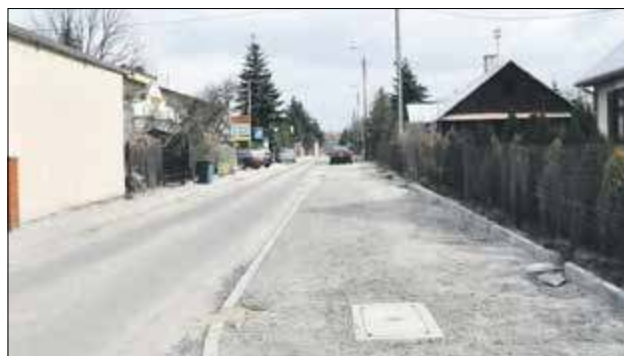
Ulica Zielona wciąż w budowie, choć przetarg rozstrzygnięto we wrześniu 2021 roku
