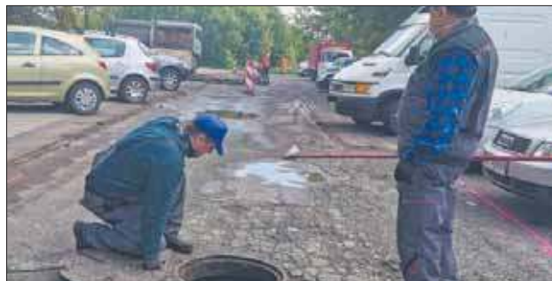
Często do sedesów trafiają różne odpady zatykające kanalizację
