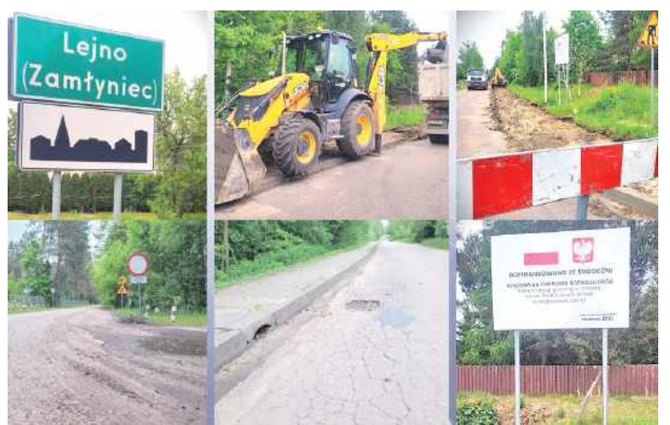
Zmodernizowanych zostanie prawie 1000 metrów nawierzchni asfaltowej
