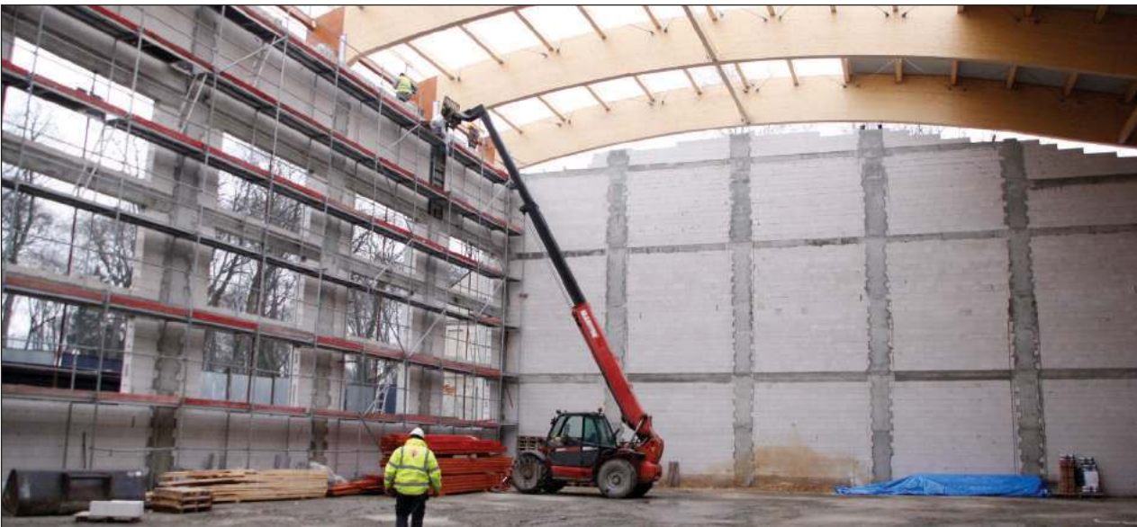
Obecnie główne prace koncentrują się na budowie dachu hali
