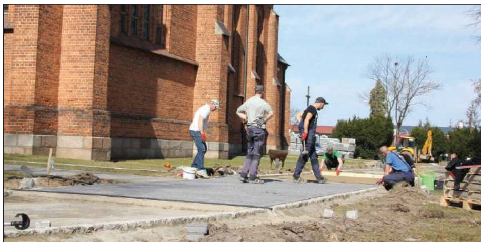
» Trwają prace przy układaniu chodnika wokół ryckiej świątyni
