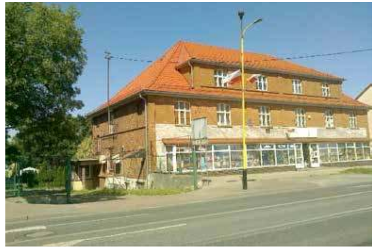
W tym obiekcie po byłym PSS miał powstać Dom Dziennego Pobytu. Świetna lokalizacja z dużym zapleczem też parkingowym Lokalizację za Wiatra zmieniono, a gminny obiekt niszczeje...
