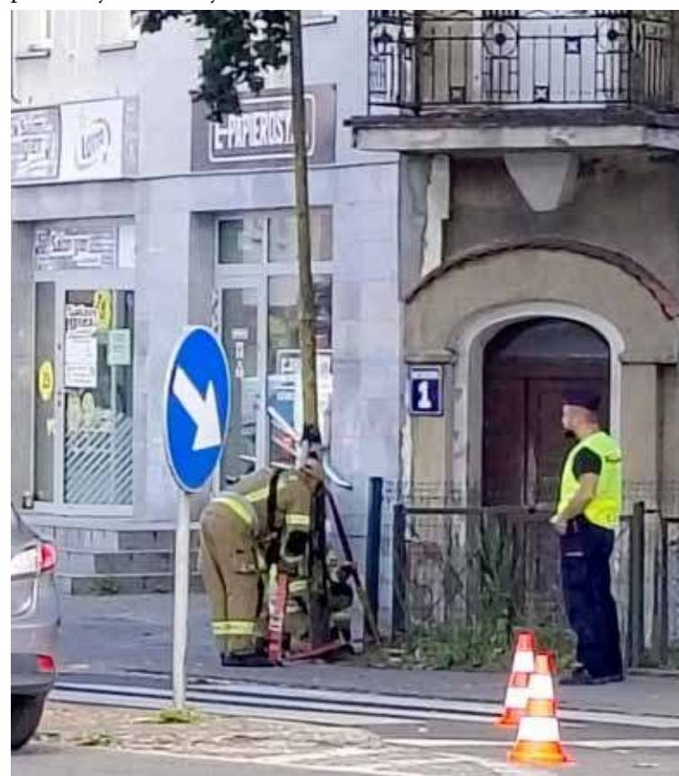
Asysta policjantów w trakcie zabezpieczania konstrukcji
