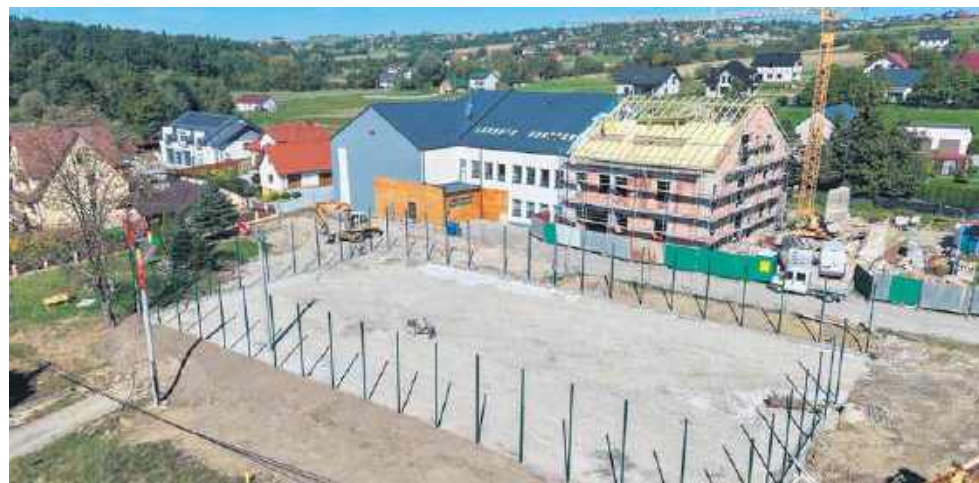
Rozbudowa szkoły i budowa boiska w Łęce
