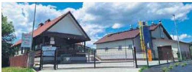
Oczyszczalnia w Tęgorz
