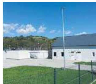
Stacja uzdatniania wody
