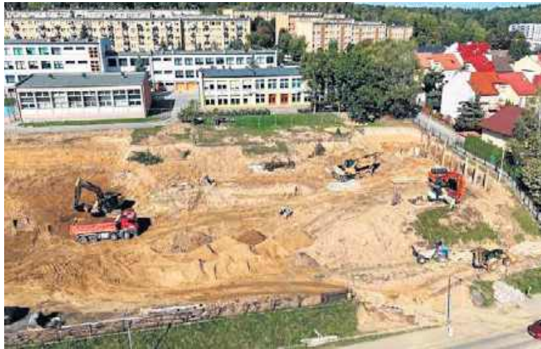
Budowa pierwszego takiego obiektu w Małopolsce trwa
