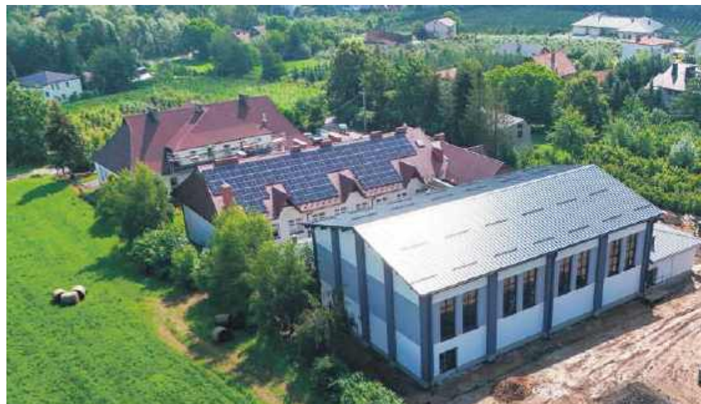
Budowa sali gimnastycznej w Czarnym Potoku
