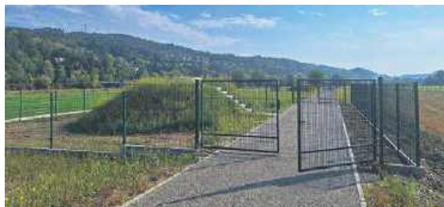
Ujęcie wody w Witowicach Dolnych
