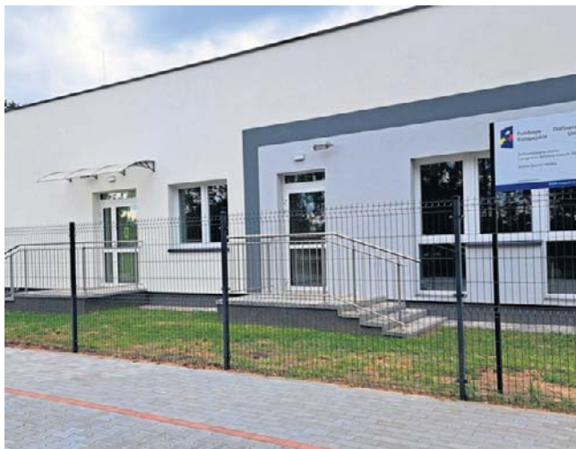
Przebudowany i rozbudowany na potrzeby utworzenia żłobka budynek przedszkola w Złejwsi Małej, otwarto w maju br.
