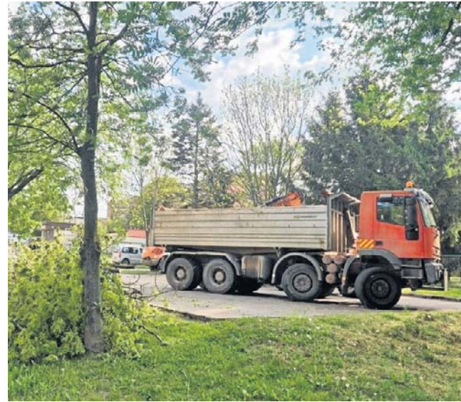
Prace budowlane przy Szpitalu Powiatowym w Lipsku już trwają. W rejonie inwestycji pojawił się ciężki sprzęt.
