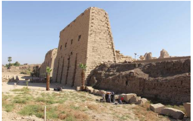
Nawiercanie gruntu i pobieranie rdzenia do analiz w pobliżu pierwszego pylonu świątyni Amona w Karnaku
