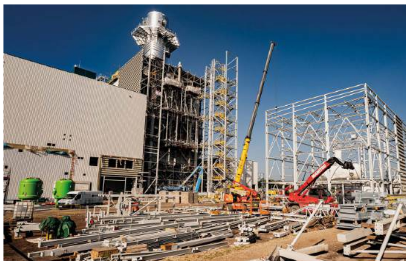
Budowany blok parowo-gazowy PGE Nowy Rybnik
