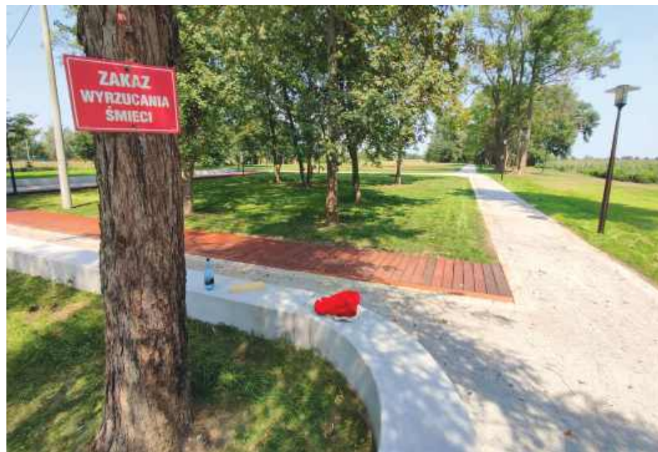
W rewitalizowanym miejscu są już wytyczone ścieżki. Zamontowano także oświetlenie, postawiono betonowe ławki i posiano trawę
