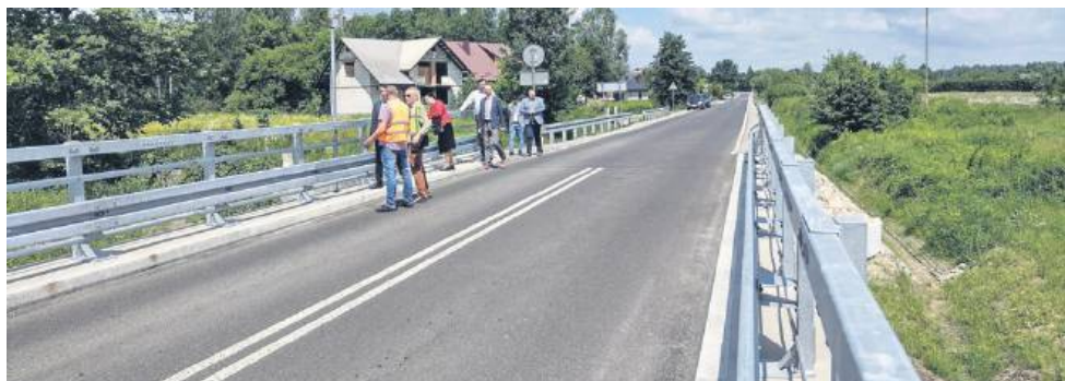
Jednym z elementów przebudowy drogi był remont mostu.
