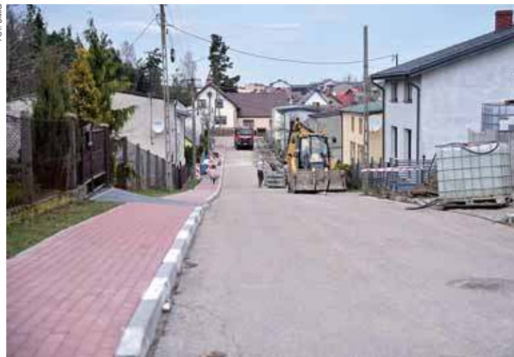
Koszt inwestycji to blisko 120 tys. zł
