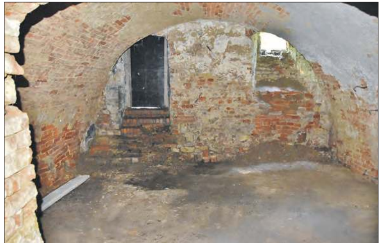
Widok na piwnicę w kierunku ściany zewnętrznej
