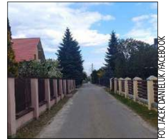
Inwestycja zostanie zrealizowana w ciągu najbliższych 9 miesięcy
