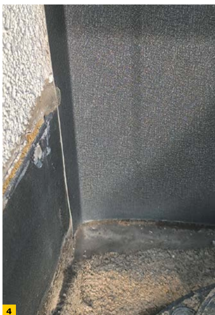
FOT. 1–5 Często spotykany sposób wykonania i „uszczelnienia” dylatacji brzegowej układów z płytami/deskami na podstawkach dystansowych/wspornikach; fot.: autor
