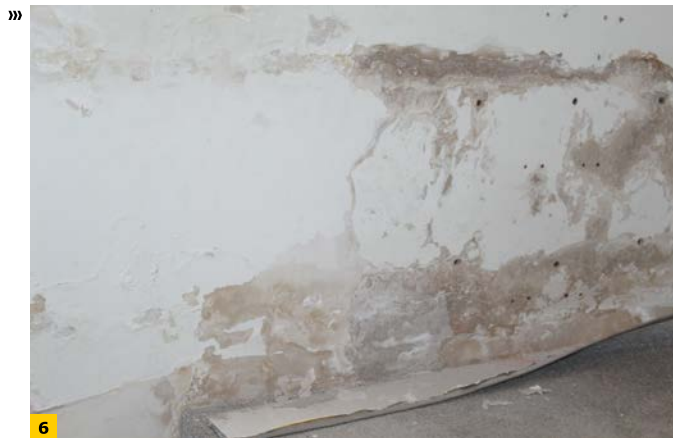
FOT. 6–7 Ściana w miejscu wykonania tarasu w sposób pokazany na FOT. 1–2; widok od wewnątrz; fot.: autor
