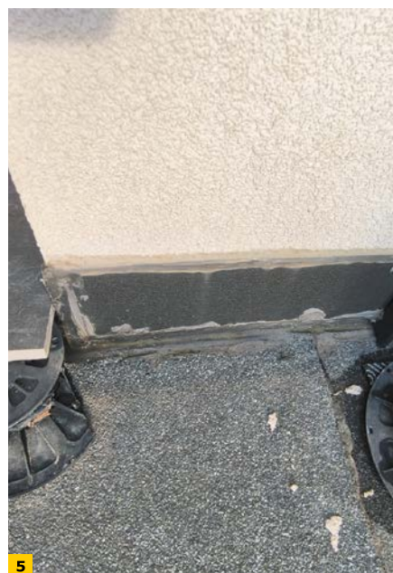
FOT. 1–5 Często spotykany sposób wykonania i „uszczelnienia” dylatacji brzegowej układów z płytami/deskami na podstawkach dystansowych/wspornikach; fot.: autor
