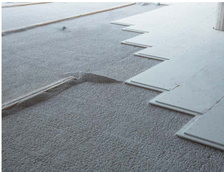
FOT. 1 System suchego jastrychu fermacell® na podsypce fermacell®
