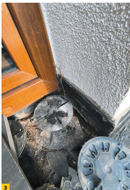
FOT. 1–5 Często spotykany sposób wykonania i „uszczelnienia” dylatacji brzegowej układów z płytami/deskami na podstawkach dystansowych/wspornikach; fot.: autor
