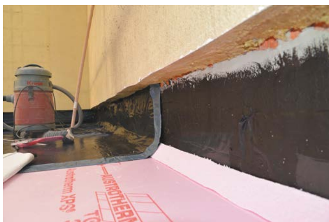
FOT. 8 Izolacja główna połaci (na termoizolacji) mocowana do części konstrukcyjnej ściany, pod termoizolacją ETICS; fot.: autor
