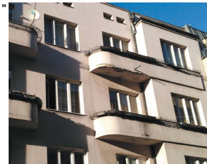
FOT. 14 Balustrada pełna + niski próg/przeście bezbarierowe wymaga szczególnej uwagi; fot.: autor
