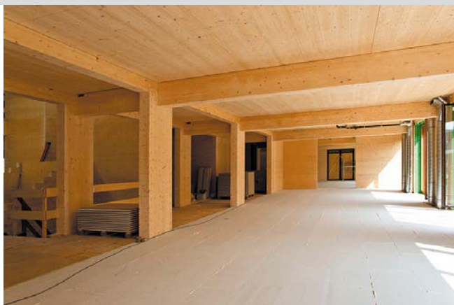
FOT. 2 System suchego jastrychu fermacell® w budownictwie szkieletowym
