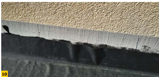
FOT. 10–11 Bezkrzytyczne przyklejenie membrany często skutkuje efektem pokazanym w.w zdjęciach; fot.: Renoplast
