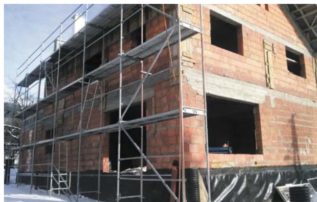
FOT. Widok budynku; fot.: autor
