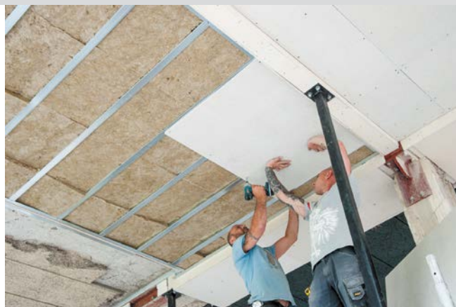
FOT. 3 Sufit podwieszany w systemie fermacell®
