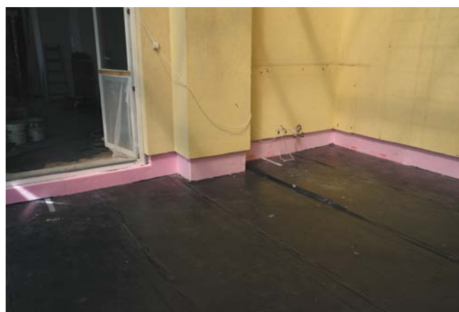
FOT. 9 Termoizolacja cokolika ułożona po wykonaniu izolacji głównej; fot.: autor
