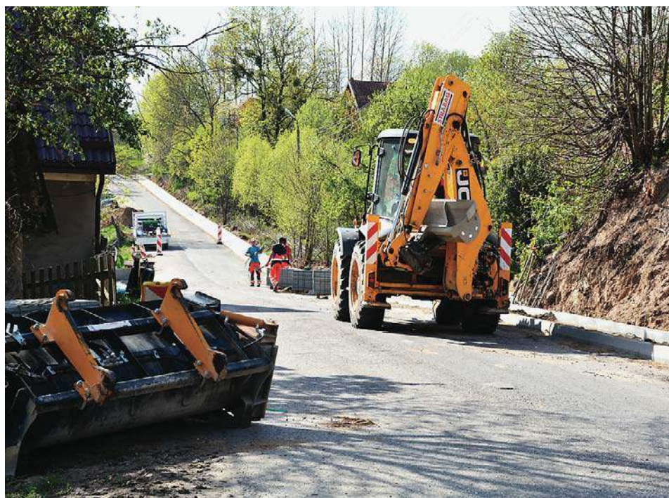
Remont drogi powiatowej na odcinku Cichy-Duły
