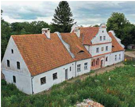
Remont „Starej Plebanii”
