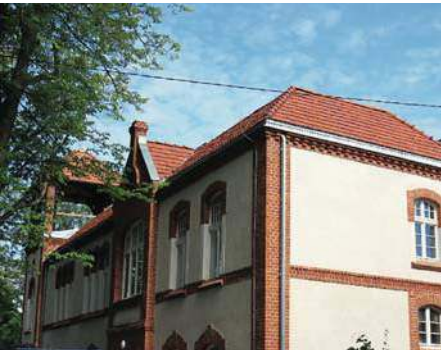
Remont Miejskiego Ośrodka Kultury
