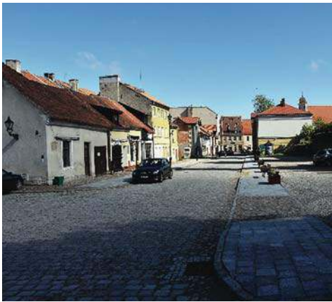
Przebudowa ul. Podzamcze
