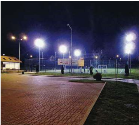
Budowa kompleksu „Orlik 2012”
