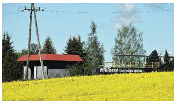
Budowa oczyszczalni ścieków i wodociągów na terenie miasta i gminy
