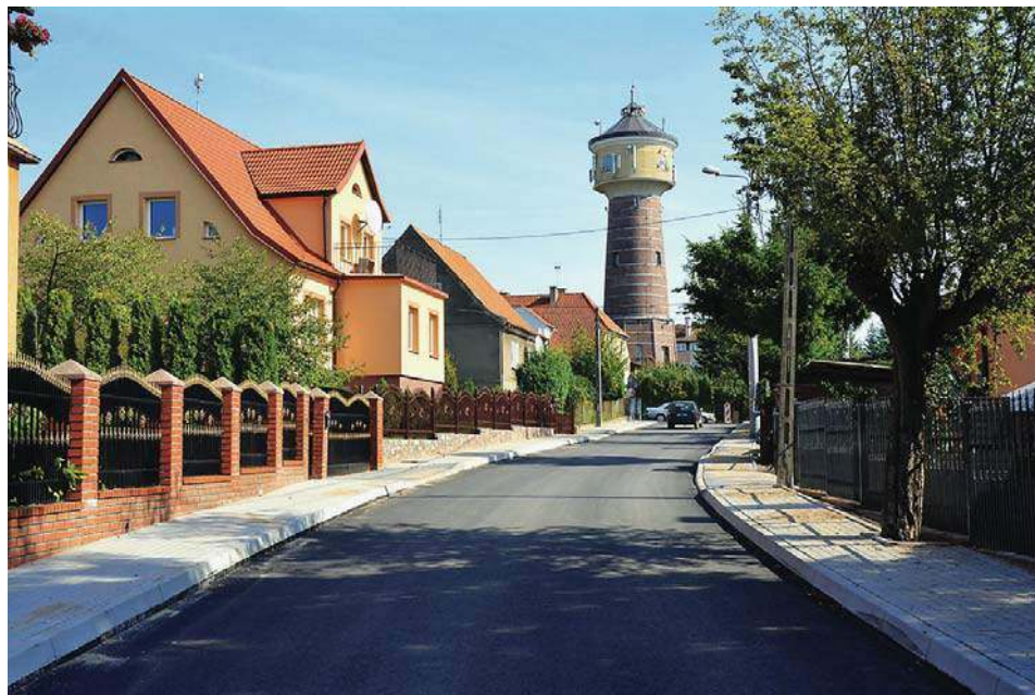
Wyremontowana ul. Przytorowa w Olecku
