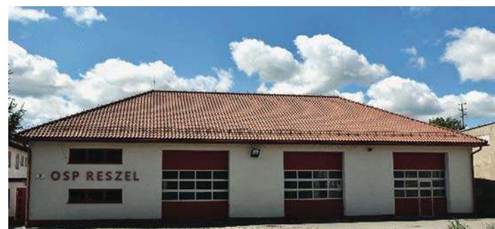
Budowa nowych garaży dla OSP Reszel
