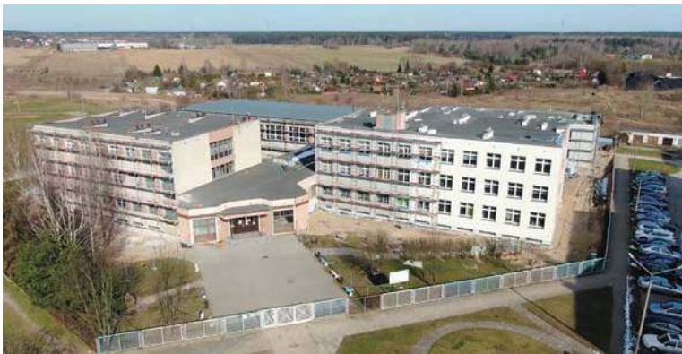
Termomodernizacja Szkoły Podstawowej nr 6
