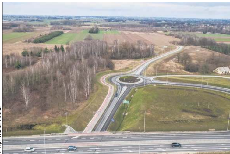
Nowy odcinek ulicy Przemysłowej połączy obwodnicę z ul. Sierpecką
