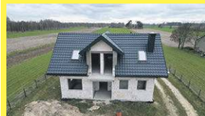
Dom w stanie surowym otwartym, Wólka Siemieńska, 885 851 160
