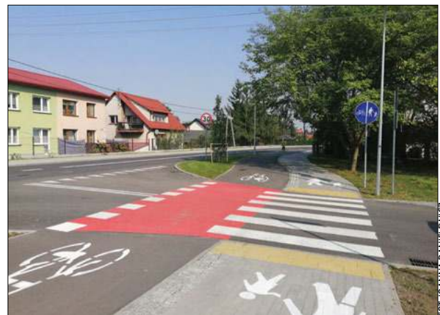
Część ul. Podleśnej została oddana do użytku. To 600 metrów zupełnie nowej drogi z całą towarzyszącą infrastrukturą
