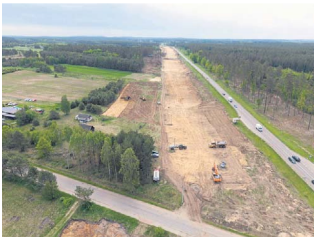
FOT. GDDKiA/STRONA KONTRAKTU
